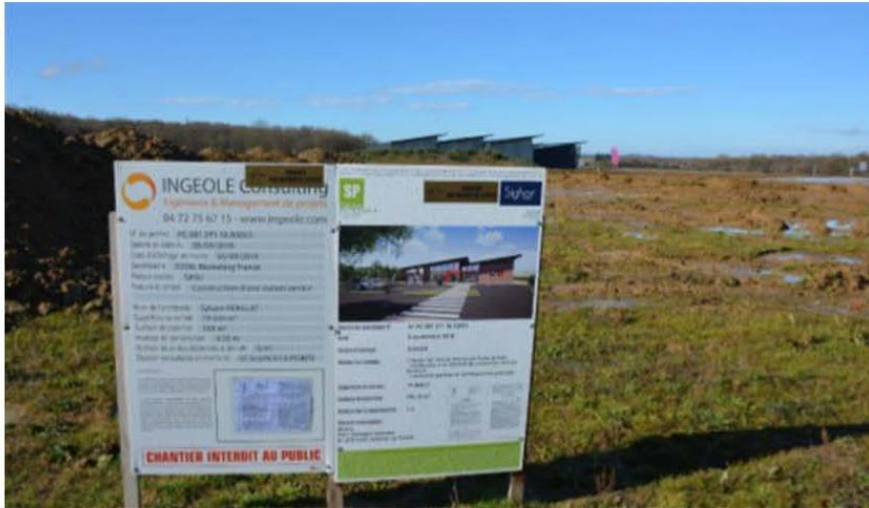
Vue du chantier
