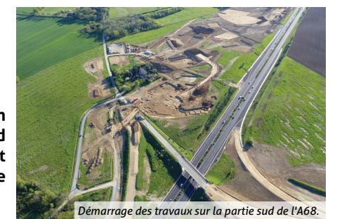
Démarrage des travaux sur la partie sud de l'A68.
