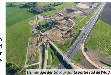
Démarrage des travaux sur la partie sud de l'A68.
