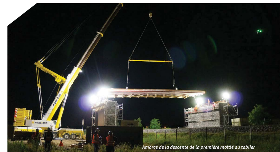
Amorce de la descente de la première moitié du tablier
